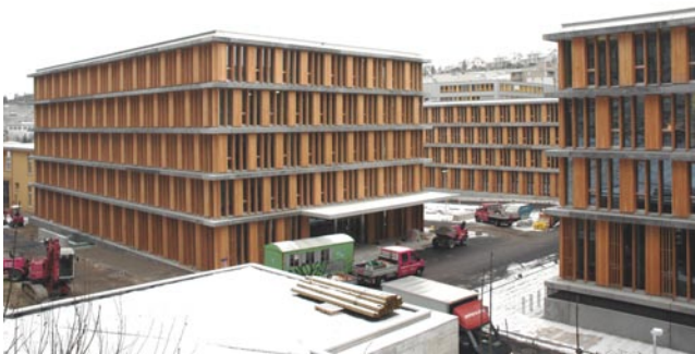
Bis vor wenigen Wochen arbeiteten Bauleute und -maschinen am neuen Verwaltungszentrum. Seit 1. März ist es Arbeitsort für über 1000 Angestellte des UVEK.
