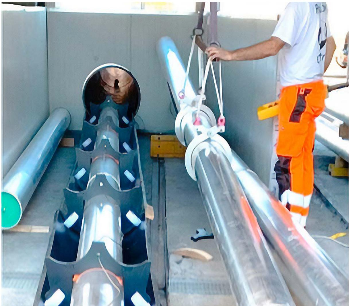
Zur Montage wird ein selbst entwickeltes Rollensystem verwendet. Das Einziehen der Kabelröhren in das Schutzrohr erfolgt über ein Zugseil (Bildquelle: Hivoduct).
