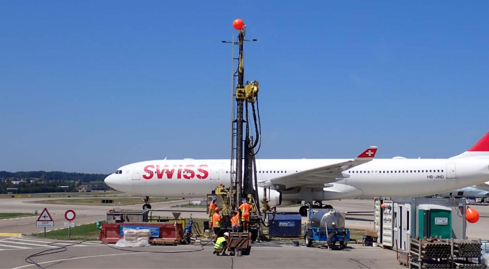
2023 wurde auf dem Gelände des Flughafens Zürich eine erste Sondierbohrung durchgeführt. Sie bestätigte, dass es an der Basis der eiszeitlichen Rinne wasserführende Schotter-schichten gibt (Bildquelle: Geo Explorers AG).
