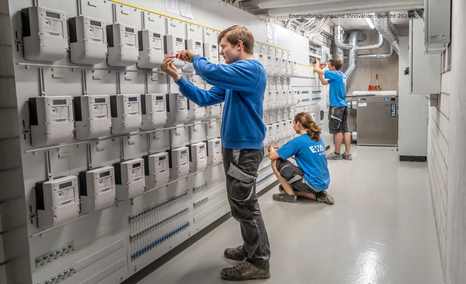
Der Umstieg von analogen Stromzählern auf digitale Smart Meter ist eine wichtige Voraussetzung, um Lastspitzen vermeiden zu können (Bildquelle: EWA-energieUri).
