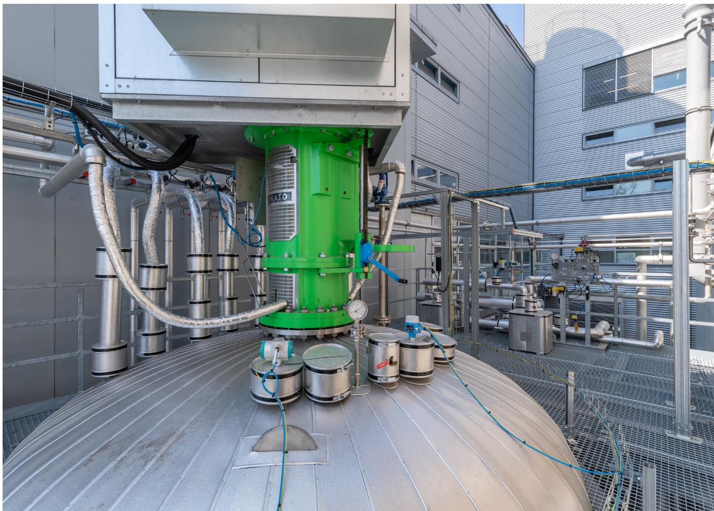
Der Bioreaktor ist acht Meter hoch und hat drei Meter Durchmesser. Im Normalbetrieb ist er mit 30 m<sup>3</sup> ausgefaultem Klärschlamm gefüllt, welcher die Mikroorganismen enthält, die das Kohlendioxid (CO<sub>2</sub>) und den Wasserstoff (H<sub>2</sub>) in Methan (CH<sub>4</sub>) umwandeln. Hierzu ist der Reaktor mit einem speziellen Rührwerk ausgerüstet. Im Reaktor herrschen 65 °C bei 7 bar Druck. Foto: Limeco
