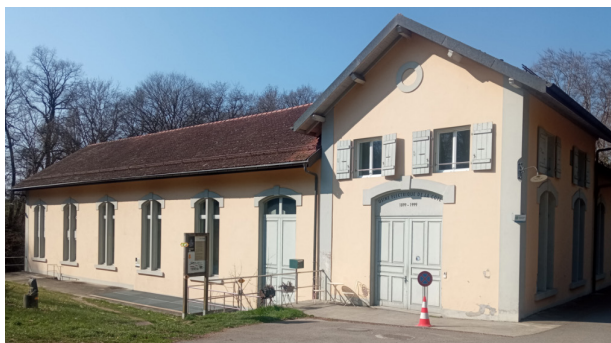
Kraftwerk von Avouillons Gland (SEIC)
