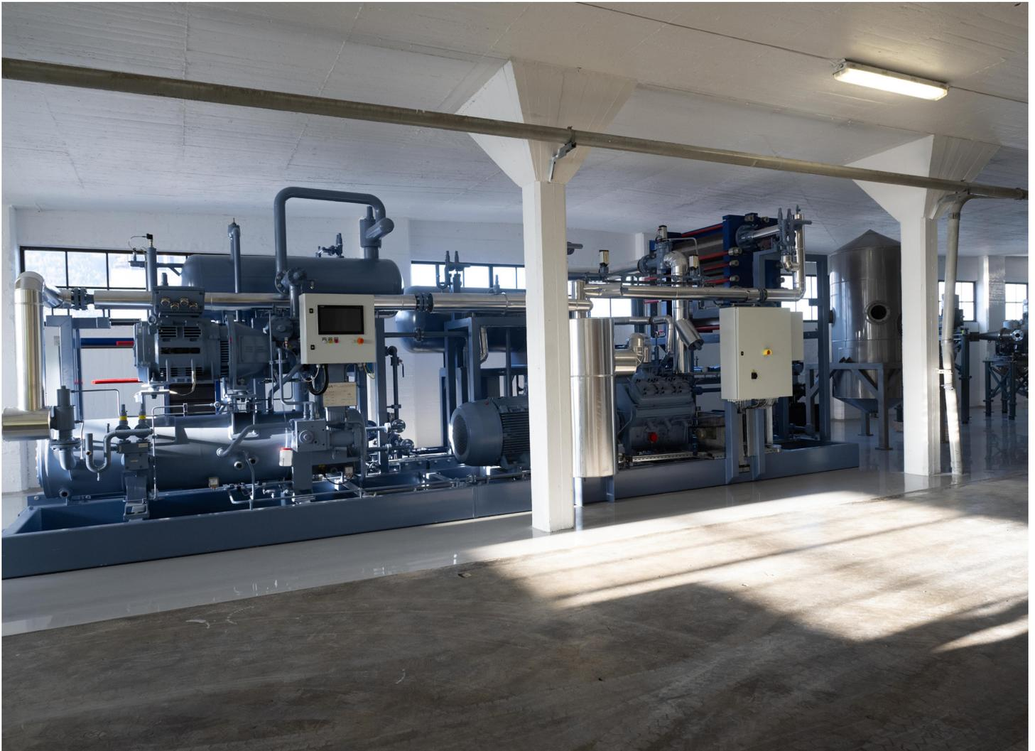
Seit 2024 ist in Trondheim (Norwegen) eine Ammoniak-Wärmepumpe in Betrieb, die in einem Werk für Tierfutter 120-gradigen Dampf mit einer Leistung von 1.6 MW bereitstellt. Foto: Aneo Industry
