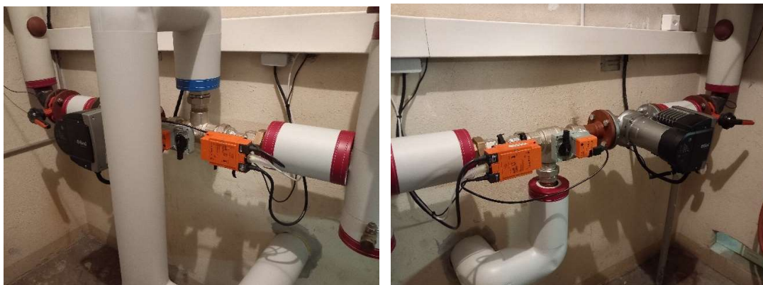
Figure 6 : Installation des vannes 3 voies Belimo Energy Valves - Secteur Ouest à gauche, secteur Est à droite
