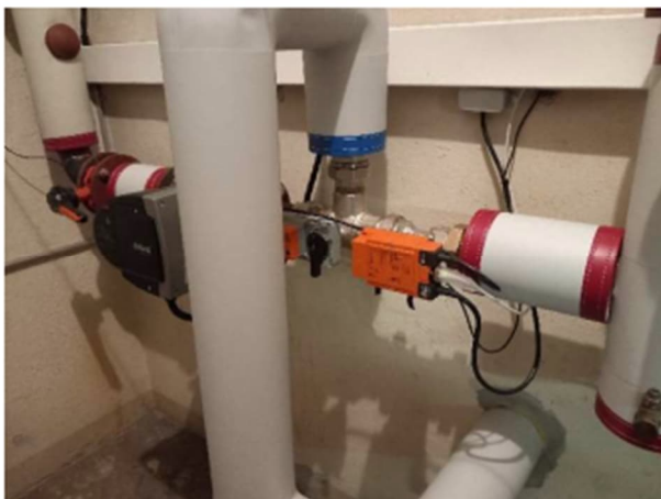
Abbildung 8: Einbau der Energy Valves, rue Dancet (Verteilung Ost links und West rechts)
