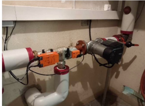
Abbildung 8: Einbau der Energy Valves, rue Dancet (Verteilung Ost links und West rechts)
