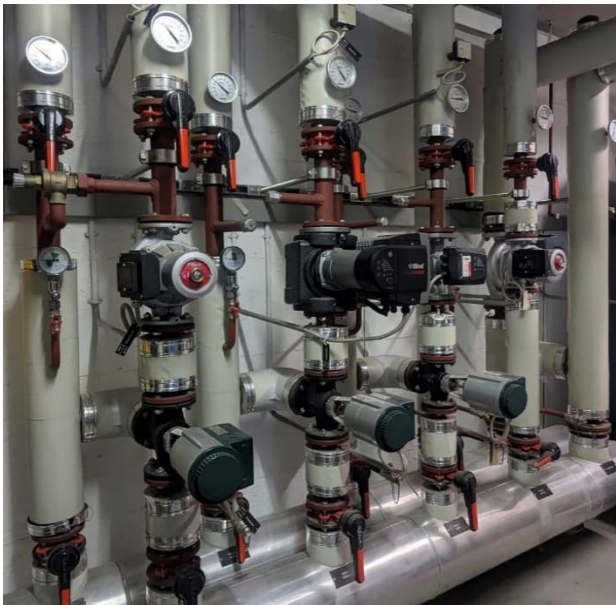
Abbildung 7: Heizverteilung Zweierstrasse vor (links) und nach (rechts) dem Umbau
