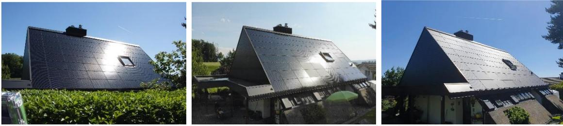
Abbildung A3-2: Links: Ausgangssituation des blendenden Norddachs. Mitte: Testfeld mit 4 blendarmen Modulen. Rechts: Blendsaniertes Dach.
