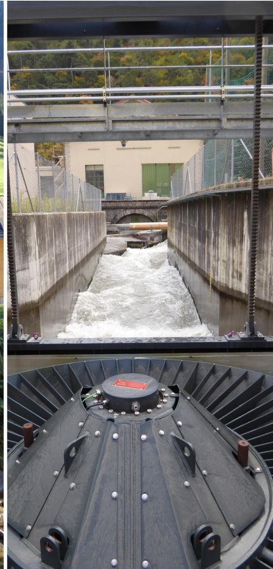
Nach 90 Jahren Stillstand wieder in Betrieb genommen: das Kleinwasserkraftwerk Furlibach mit 6-düsiger Pelton-Turbine und Generator (linkes Bild) und Krafthaus von aussen (rechtes Bild), © fmb Ingenieure
