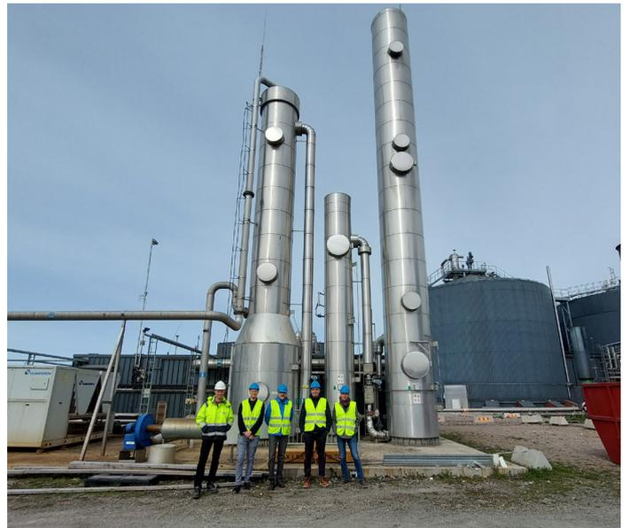
Mitglieder des schweizerisch-schwedischen Projektteams vor der Biogasanlage von Uppsala Vatten in Uppsala (Schweden). Die Biogasanlage trennt das  $\text{CO}_2$  aus dem Rohbiogas ab, damit qualitativ hochwertiges Biogas mit einem Methananteil von nahezu 100 % entsteht. Foto: OST
