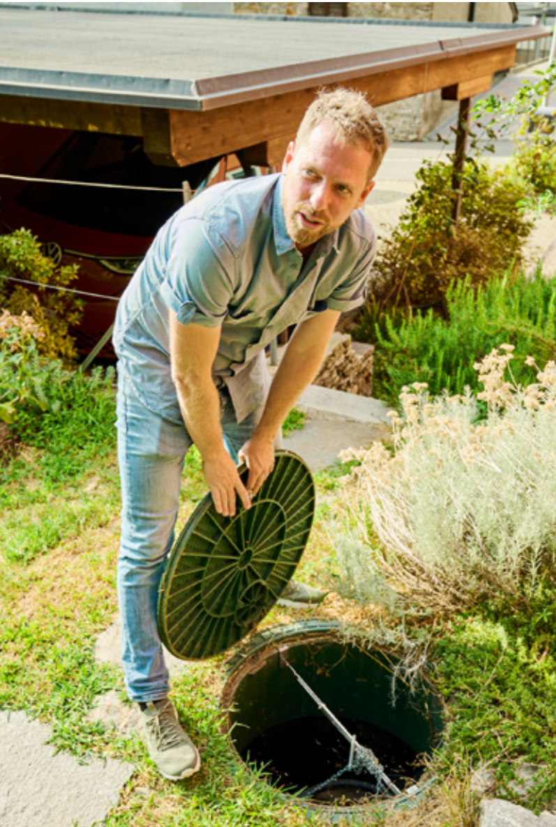
Alberto Conelli liess einen 3000-Liter-Tank im Boden versenken, in dem er Regenwasser vom Dach sammelt.
