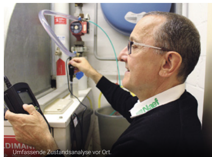
Umfassende Zustandsanalyse vor Ort.
