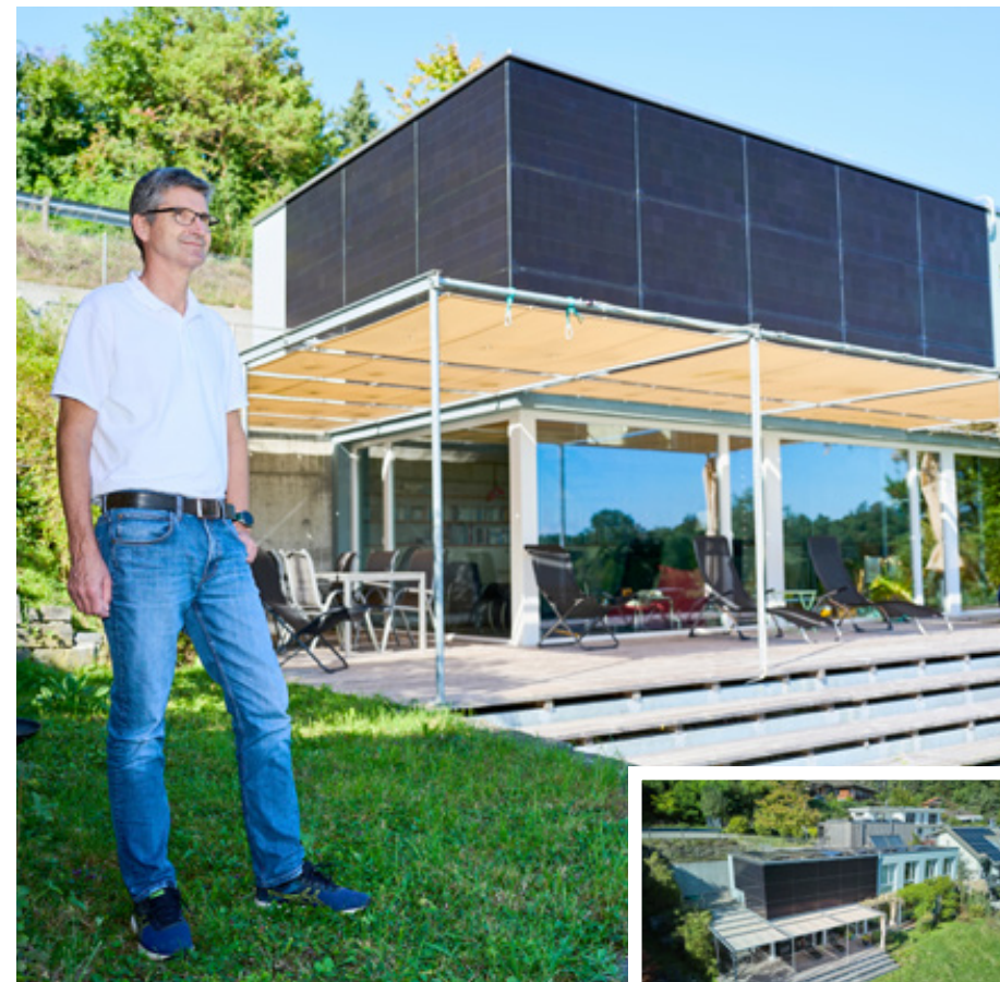
Jürg Beriger hat den fensterlosen Teil seines Hauses in Lostorf SO nachträglich mit PV-Paneelen ummantelt.
