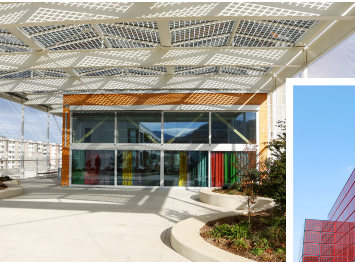
Auf dem Dach der Primarschule Allmend in Zürich-Wollishofen ist ein Allwetterplatz mit integrierter PV-Anlage ergänzt.
