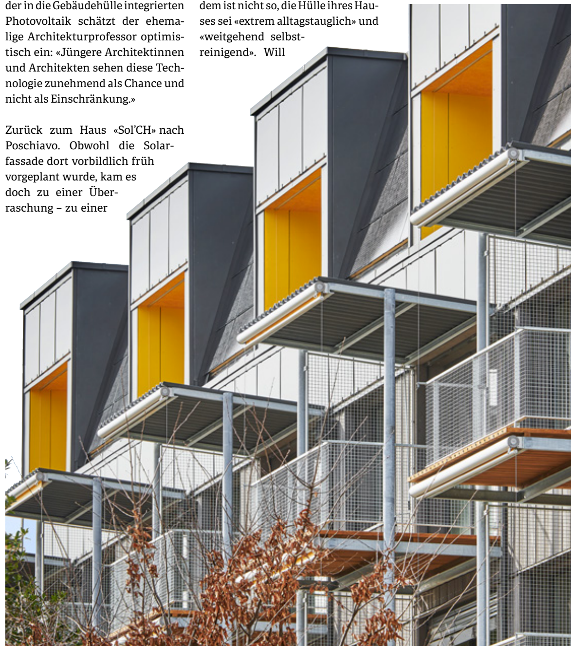
Bei der PV-Fassade der «Maison Climat» in Biel wurden Kosten und Leistung optimiert. (Foto: Damian Poffett)
