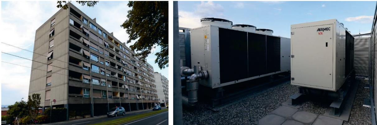
Figure 3: gauche: vue de l'immeuble; droite: les deux PAC air-eau de type industriel installées en toiture
