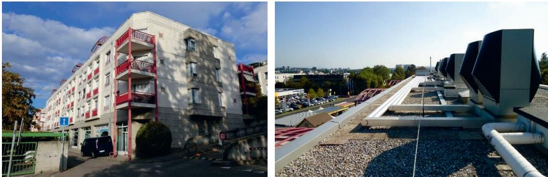
Figure 4: gauche: l'immeuble; droite: les six PAC air-eau de type villa installées en toiture
