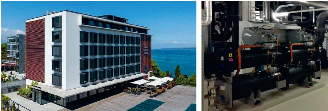
Figure 7: gauche: un des 7 bâtiments raccordés; droite: la PAC sur eau du lac pour production de chaleur et de froid
