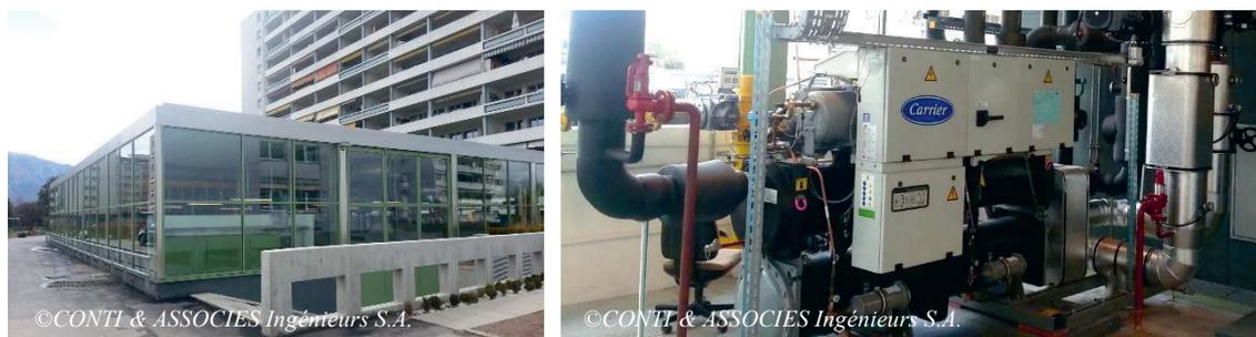
Figure 2: gauche: Chauffage du CAD Laurana; droite: PAC eau-eau pour la récupération de chaleur des fumées des chaudières, et connectée à un champ de sondes géothermiques
