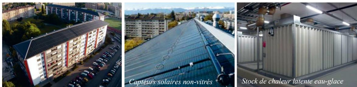
Figure 5: gauche: vue des bâtiments; milieu: capteurs solaires thermiques non-vitrés sur le toit; droite: cuve du stockage de chaleur latente eau-glace
