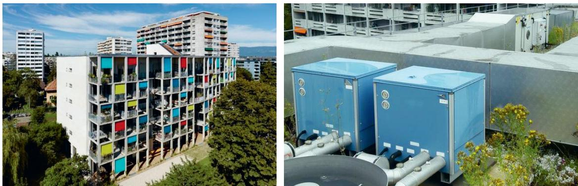
Figure 10: gauche: L'immeuble; droite: les deux PAC sur air vicié en toiture avec monoblocs à l'arrière-plan
