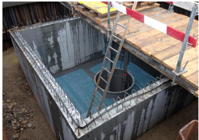
Grundwasserbrunnen in Aarau mit 1.8 MW
