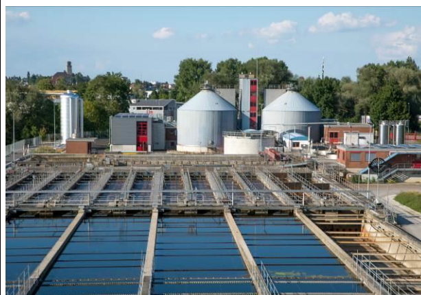
Kläranlage Morgental (SG)
