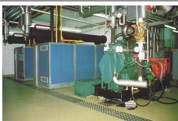
Gasmotor-Wärmepumpenanlage
