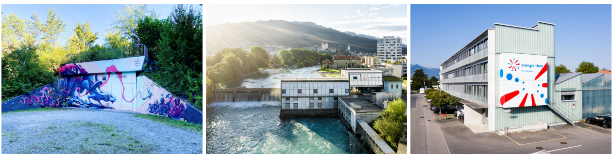
Abbildung 1: Sowohl das Grundwasserpumpwerk Lerchenfeld, die Aarewerke Thun wie auch das Betriebsgebäude unterstehen der Zielvereinbarung.
