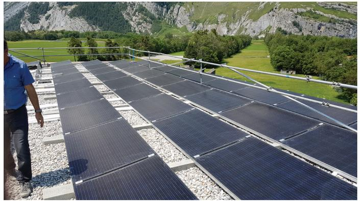
Die doppelt verglasten PVT-Module produzieren Strom und Wärme. Sie werden aber auch eingesetzt, um das Gebäude zu kühlen. Das PVT-System ist auf den Kühlfall optimiert. Wäre das System auf den Wärmeertrag optimiert, könnte etwa 20-mal mehr Wärme gewonnen werden. Foto: SPF/Vassella
