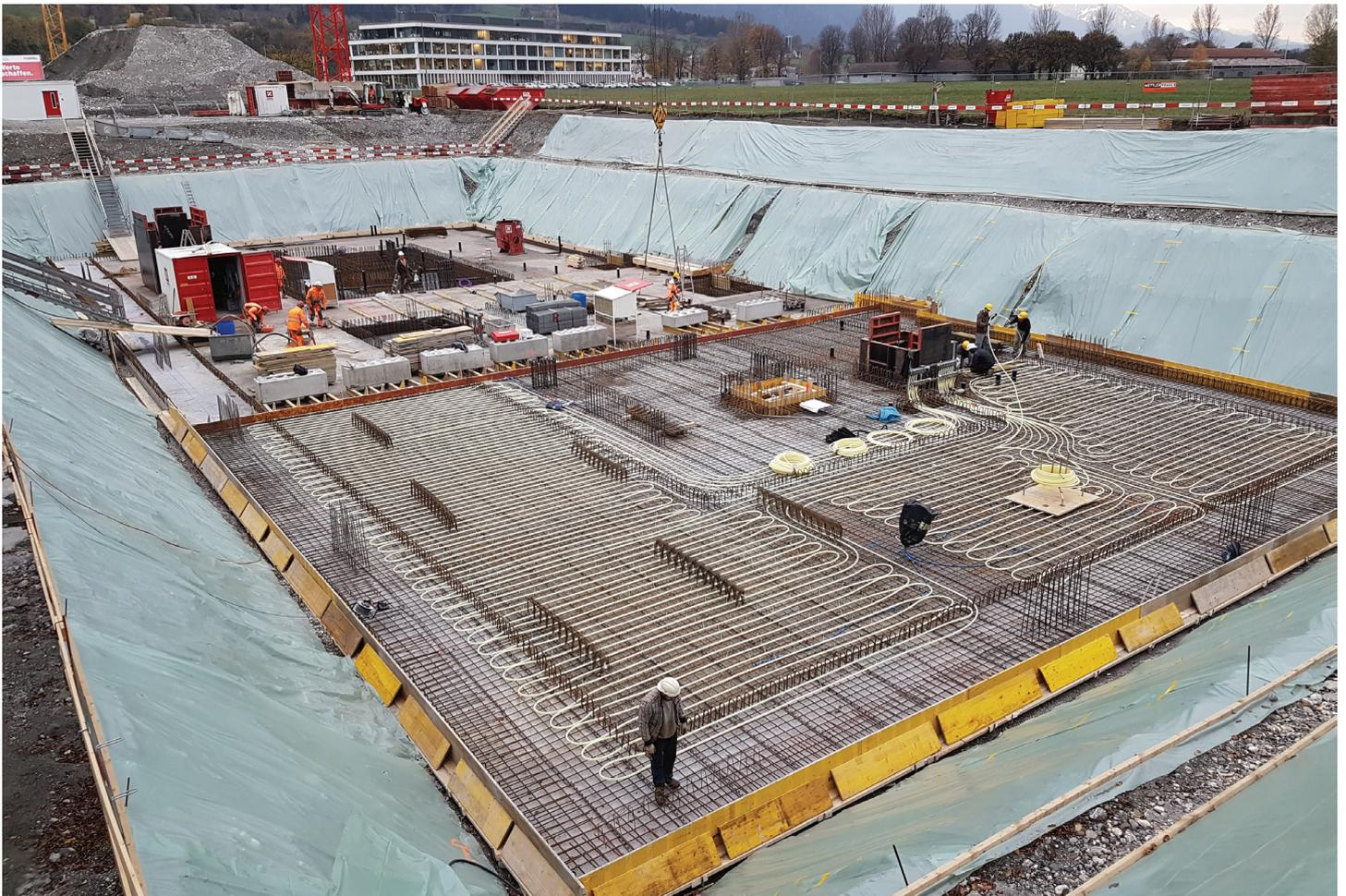
Die Fundamentplatte mit den eingelegten Wärmetauscher-Rohren in der Bauphase. Foto: BFE-Schlussbericht OblaTherm
