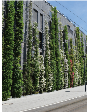
Beispiel für eine «bodengebundene» Begrünung: Stadthaus «M1» im deutschen Freiburg. Foto: BuGG
