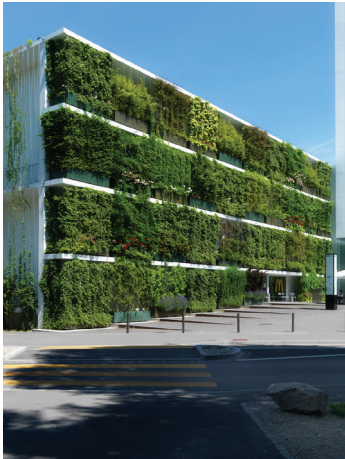
Beispiel einer «wandgebundenen» Begrünung: Stüchi-Einkaufszentrum in Basel. Die Begrünung besteht aus 23 verschiedenen Gehölzarten und Kletterpflanzen. Die Pflanzen befinden sich in Trögen und ranken sich an Seilen empor. Foto: Beat Breitenfeld
