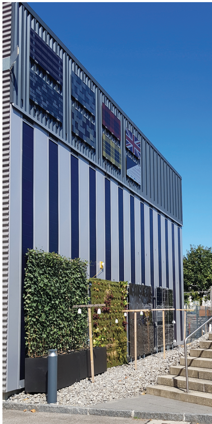
Auf dem HSLU-Campus wurden vier Fassadensysteme ausgemessen (von links nach rechts): boden-gebundene Begrünung, wandgebundene Begrünung, opake PV-Anlage, transparente PV-Anlage. Foto: Schlussbericht GreenPV
