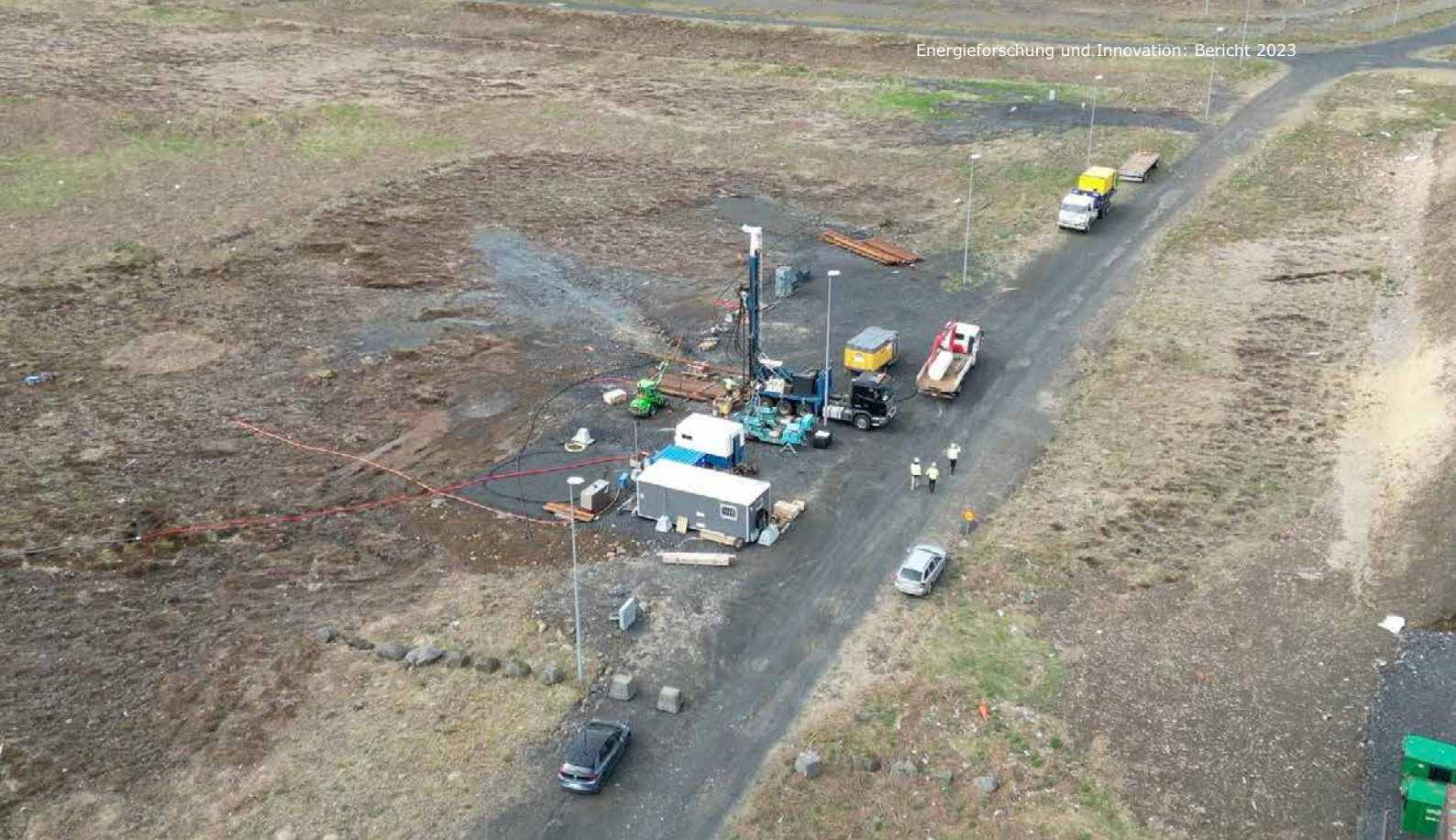
An zwei Standorten in Island wird das CO 2 mit Süsswasser und erstmals auch mit Meerwasser vermischt und in den Basalt injiziert. (Bildquelle: DemoUpCARMA/ETH Zürich).
