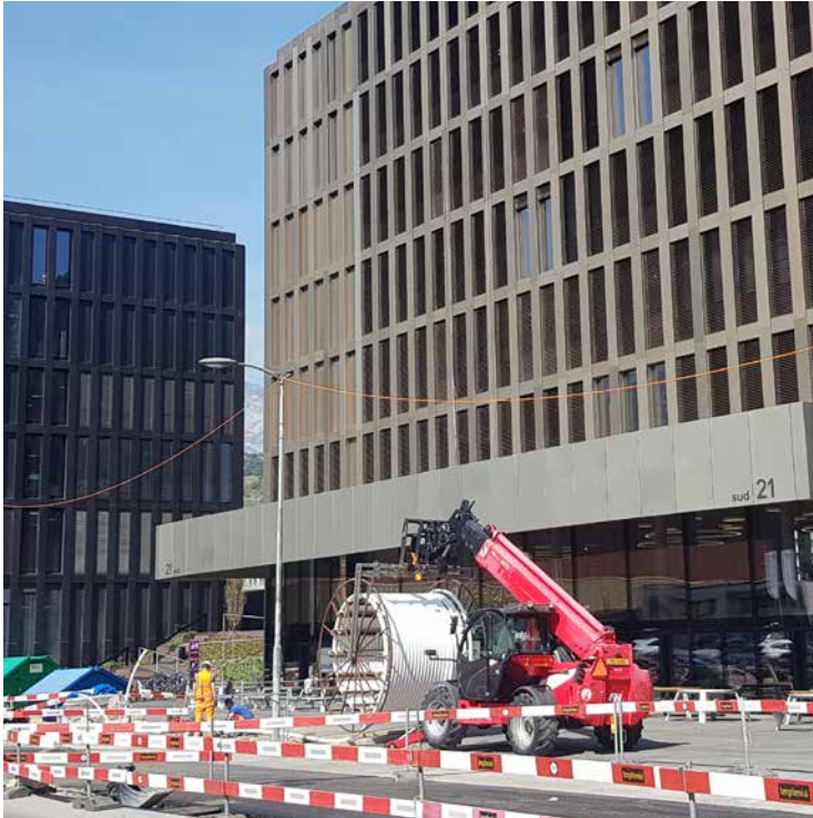
Die weissen Rohre wurden von der Spule in den Untergrund verlegt und transportieren nun das CO 2 . Dank des im Vergleich zu Wasserrohren geringeren Querschnitts mussten weniger tiefe Baugrubenausgehoben werden (Bildquelle: HES-SO Valais-Wallis).
