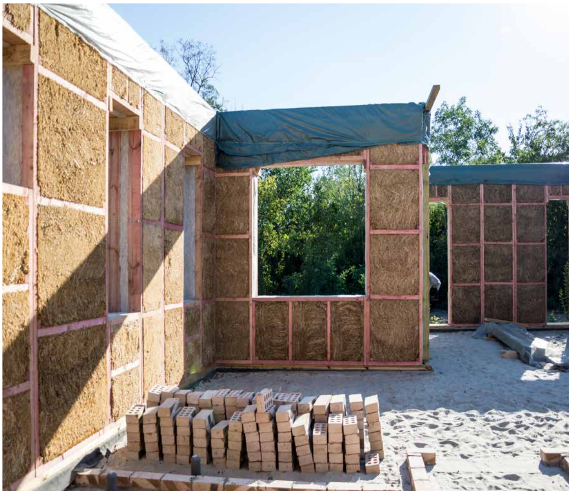
Die Leichtbauweise, wie der hier gezeigte Holzrahmenbau mit Strohdämmung, belastet Klima und Umwelt generell weniger stark als der Massivbau mit keramischen oder mineralischen Baustoffen wie Ziegelsteine oder Beton (Bildquelle: Shutterstock).
