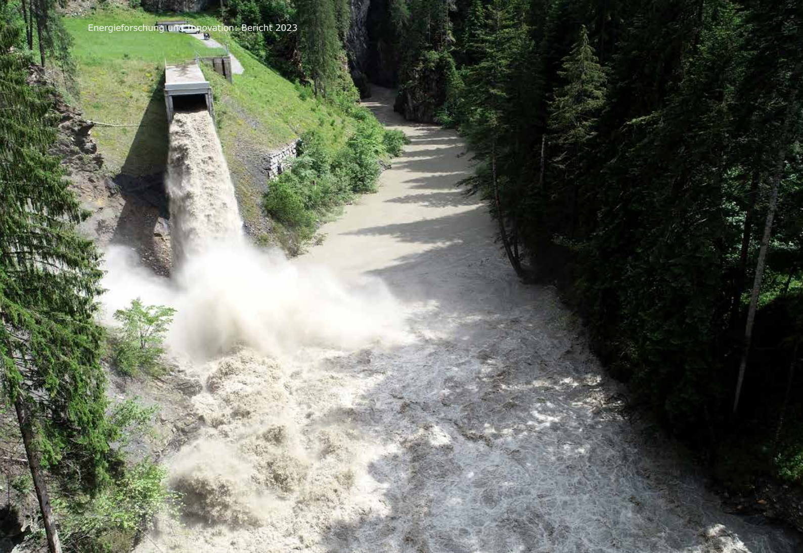
Der Auslass des Umleitungsstollens an der Albula, über den das Geschiebe am Solis-Staudamm vorbeigeleitet wird (Bildquelle: VAW ETH Zürich).
