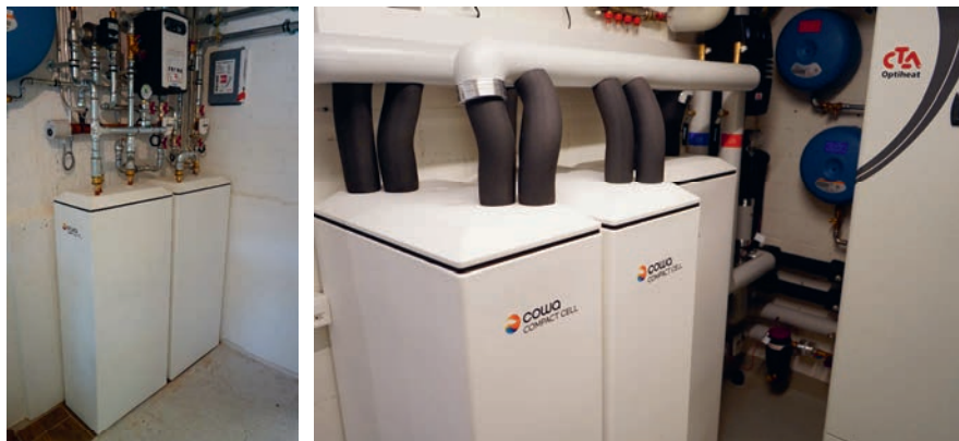
Abbildung 15: Zwei Installationsbeispiele von Pilotanlagen, umgesetzt in Q3 2024: Warmwasser- und Pufferspeicher (links) sowie drei Pufferspeicher (rechts).
