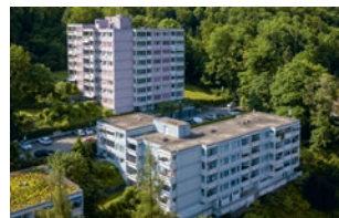
Pilotanlage im P&D-Projekt «Renosource» zum Kesseleratz im Leistungsbereich 200 kW
