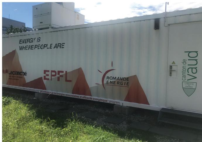
Dieser Batteriespeicher mit einer Kapazität von 560 kWh half mit, die Ladestationen bei der EPFL netzdienlich zu betreiben. Foto: MESH4U
