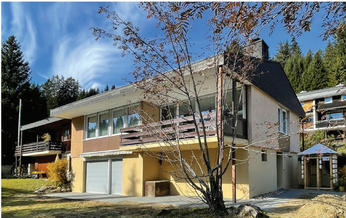
Das Ferienhaus in Lenzerheide, dessen Erdgeschoss-Fassade mit einem Aerogel-Dämmputz von 6 cm Stärke versehen wurde. Vor dem Aufbringen des Dämmputzes wurde die Fassade beschichtet, um die Beständigkeit des Dämmputzes zu erhöhen. Foto: Daniel Sanz Pont
