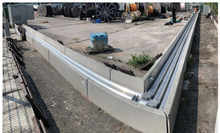
Mittelspannungs-Druckluftkabel (36 kV) mit drei nebeneinander liegenden Phasen, verlegt in einem Kabelkanal. Foto: Hivoduct
