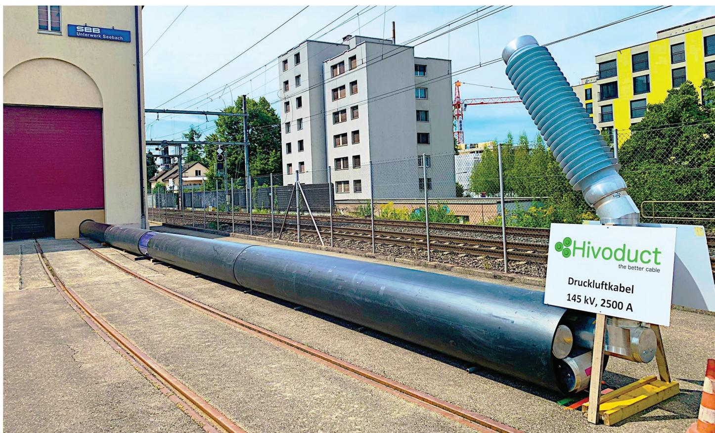
Teil der Demonstrationsanlage für Druckluftkabel bei der SBB-Schaltanlage in Zürich-Seebach: Rechts im Bild ist zu erkennen, dass in dem Schutzrohr drei Druckluftkabel untergebracht sind. Jedes davon ist eine Phase des dreiphasigen Hochspannungskabels. Auch an heissen Sommertagen und bei einem maximalen Strom von 2000 Ampère erhitzen sich die Druckluftkabel nicht auf mehr als 57 °C. Foto: Hivoduct
