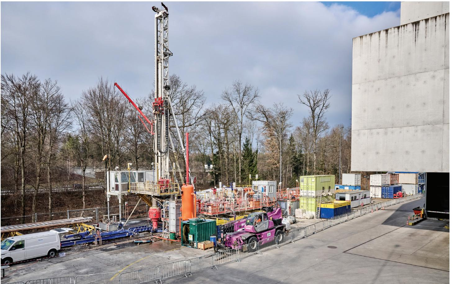
Wie Genf befasst sich auch Bern mit der Idee eines Aquiferspeichers. Im Bild: Bohrloch für den Geospeicher von Energie Wasser Bern. Bei einem Erfolg des Pilotprojekts könnte hier im Sommer künftig 90-gradiges Wasser aus der KVA in Sandsteinschichten gespeichert und im Winter dann von dort ins städtische Wärmenetz eingespeist werden. Foto: Energie Wasser Bern
