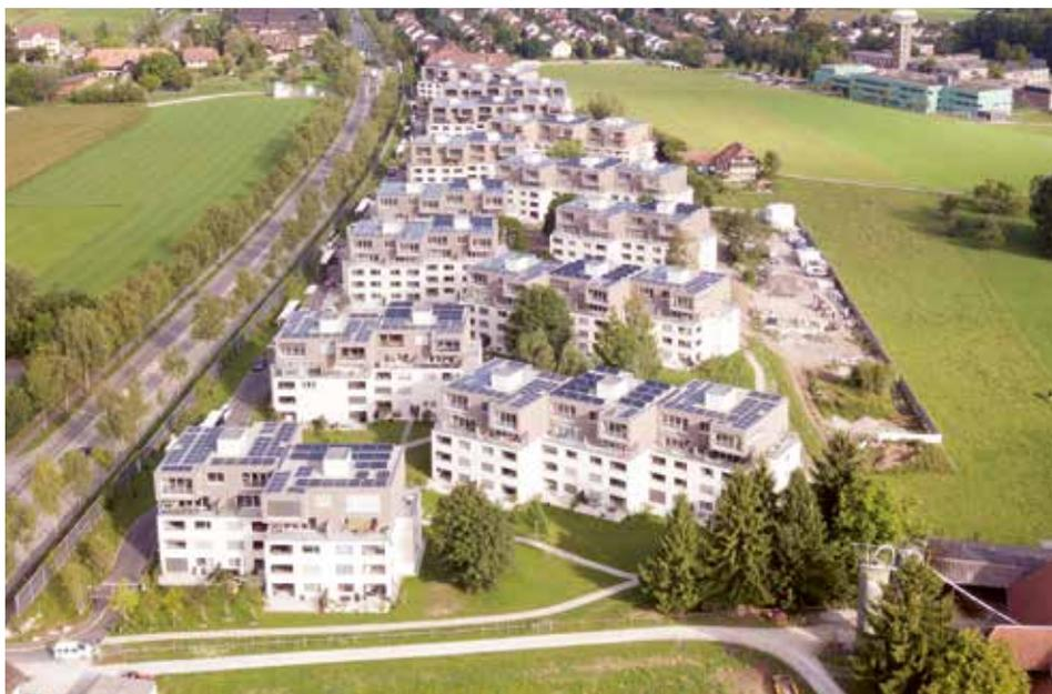
Bild 1.2: Verdichtung durch Aufstocken – Siedlung Nessleren in Wabern BE. (Quelle: Previs Vorsorge)
