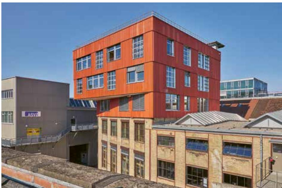
Bild 12.25: Eine Laterne für das zirkuläre Bauen: Die Fassaden und die Tragstruktur des Kopfbaus sind mehrheitlich aus wiederverwendeten Bauteilen zusammengesetzt. (Quelle: Baubüro Insitu/Martin Zeller)
