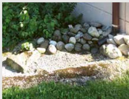
Bild 10.4: Einfache Methode, um Regenwasser an der Oberfläche zu halten: Statt es direkt in der Kanalisation zu entsorgen, wird es oberirdisch zu einer Versickerungsmulde geführt. (Quelle: Verband Schweizer Abwasser- und Gewässerschutzfachleute)
