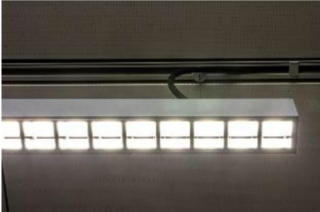
Abbildung 14: Pendelleuchte Zumtobel LINCOR, technische Daten gemäss Datenblatt (Quelle: Hochschule Luzern)
