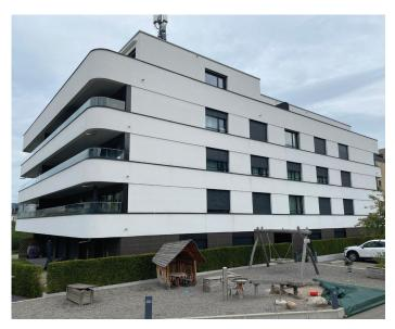
Dieses Mehrfamilienhaus ist sehr gut gedämmt und hat einen Heizwärmeverbrauch (inkl. Luftvorwärmung für die Lüftungsanlage) von lediglich rund 17 kWh/(m²a). Mit einer installierten Heizleistung von 58 kW bzw. 19.3 W/m² ist die Heizung deutlich (160 %) überdimensioniert. Foto: BFE-Schlussbericht OptiPower
