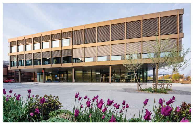
Ein modernes Hochschulgebäude auf dem Campus Rapperswil der Ostschweizer Fachhochschule. Mit 26.4 kWh/(m²a) hat das Gebäude einen geringen Heizwärmebedarf; für die Beheizung würde eine Heizung mit einer Leistung von rund 15 W/m² ausreichen. Tatsächlich installiert ist aber eine Heizung mit 42 W/m², die Heizanlage ist also um 180 % (Faktor 2.8) überdimensioniert. Foto: BFE-Schlussbericht OptiPower
