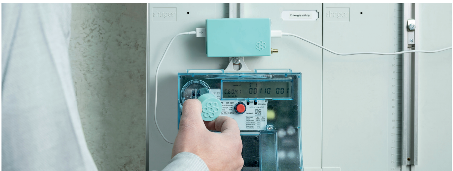
Abbildung 2: Um den Echtzeitstromverbrauch zeitgleich auf die App zu erhalten, wird ein Gateway an den Stromzähler montiert. Die Gateways sind für «cleverStrom»-Kund:innen gratis. (Bild: ibw)
