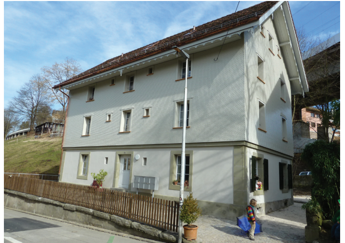
Dieses Drei-Familien-Haus im Berner Lorraine-Quartier wird seit der Sanierung im Jahr 2013 von einer Erdsonden-Wärmepumpe (13 kW) mit Heizwärme und Warmwasser versorgt. Foto: eicher+pauli
