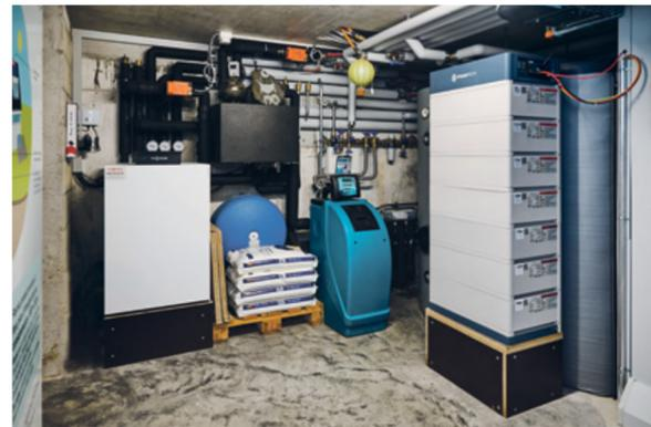
Der Technikraum im Untergeschoss, wo Wärmepumpe, Strom- und Wärmespeicher installiert sind.
