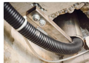
Durch den alten Kamin erfolgt heute die Kabelführung der Solaranlage.
