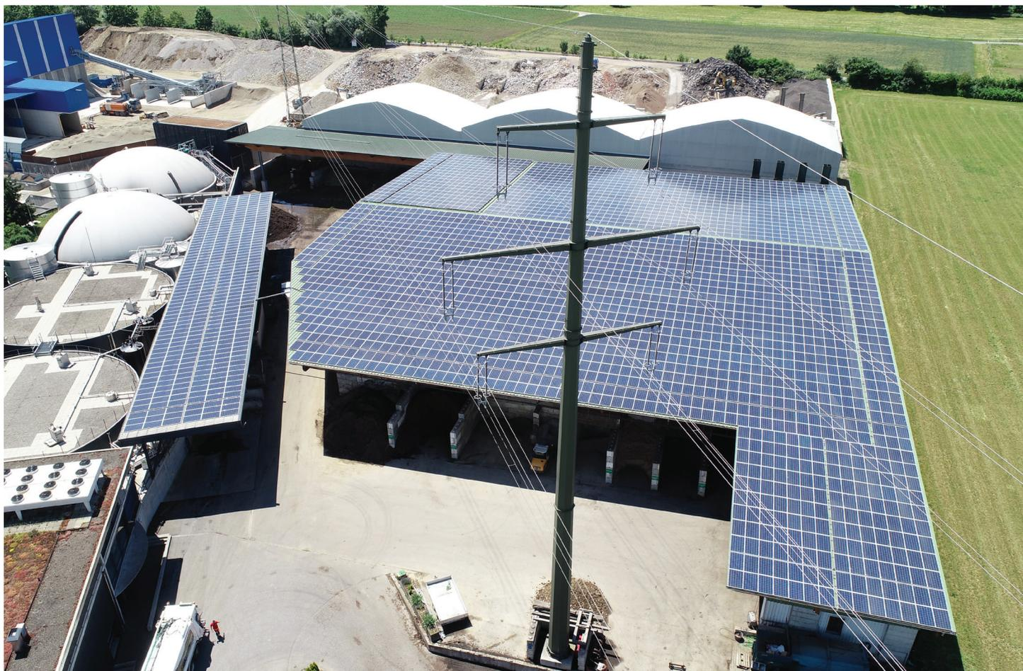
Die PV-Anlage in Tägerig im aargauischen Bezirk Bremgarten. Die Anlage, die von der AEW als Contractorin betrieben wird, hat eine Spitzenleistung von 865 kW<sub>p</sub>. Sie wird seit Ende 2022 zur Bereitstellung von (induktiver) Blindleistung herangezogen. Foto: AEW
