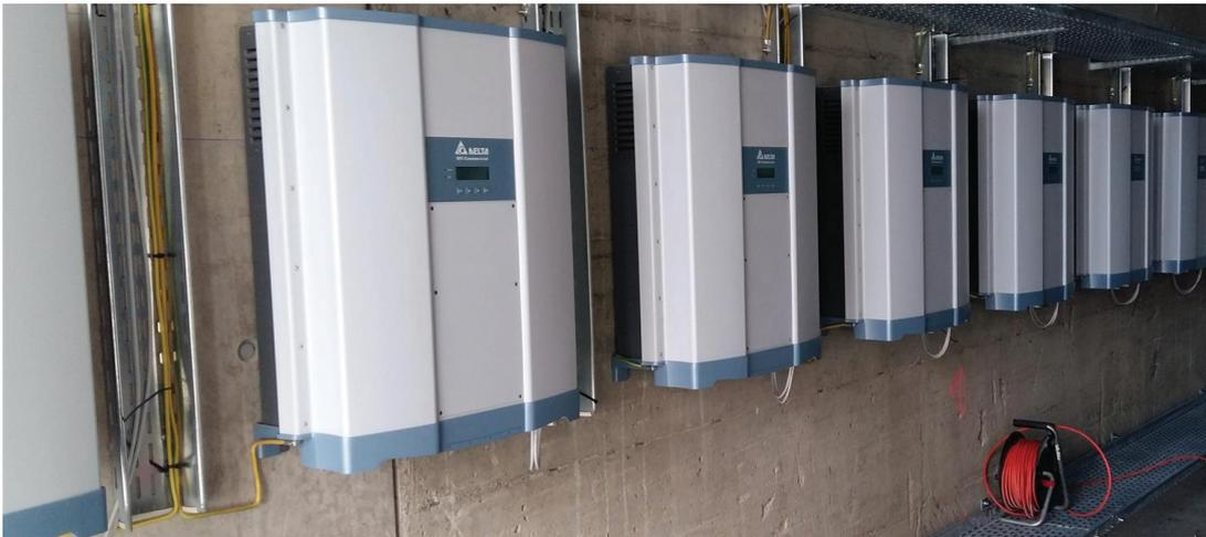
Die Wechselrichter der PV-Anlage in Tägerig können (induktive) Blindleistung von bis zu 480 kvar bereitstellen. Das ergibt pro Jahr bei angenommenen 1000 Volllaststunden 480 Mvarh Blindenergie. Die AEW baut gegenwärtig einen grossen Netzbatteriespeicher. Dieser wird voraussichtlich im November 2023 in Betrieb genommen und hat das Potenzial, rund das Vierfache an Blindleistung bereitzustellen. Foto: AEW
