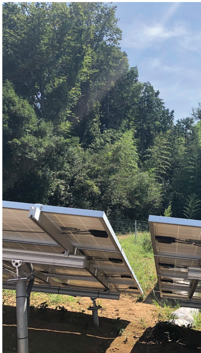
Optimizer haben das Potenzial, den Solarertrag zum Beispiel bei einer starken Teilverschattung durch Bäume zu steigern. Foto: Tigo Energy
