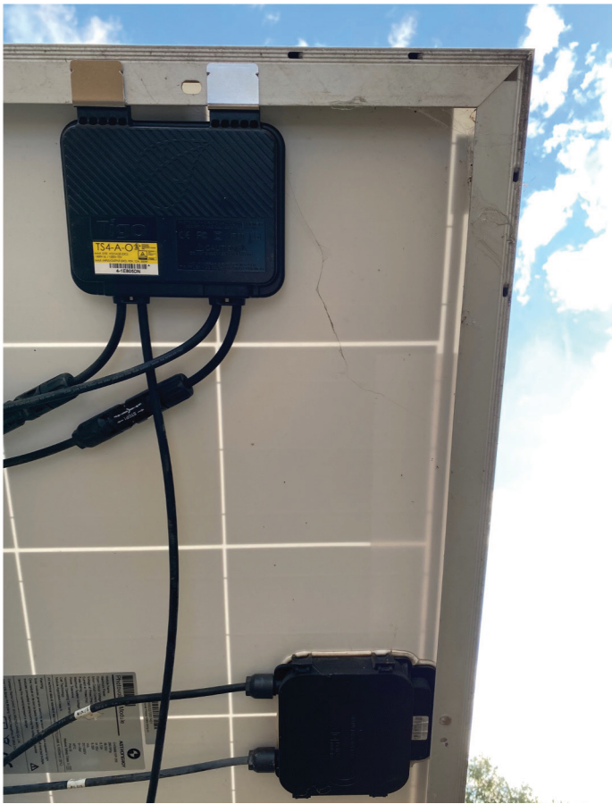
Leistungsoptimierer werden direkt am Photovoltaik-Modul angebracht und sind einer erheblichen Wärmebelastung ausgesetzt. Foto: Tigo Energy
