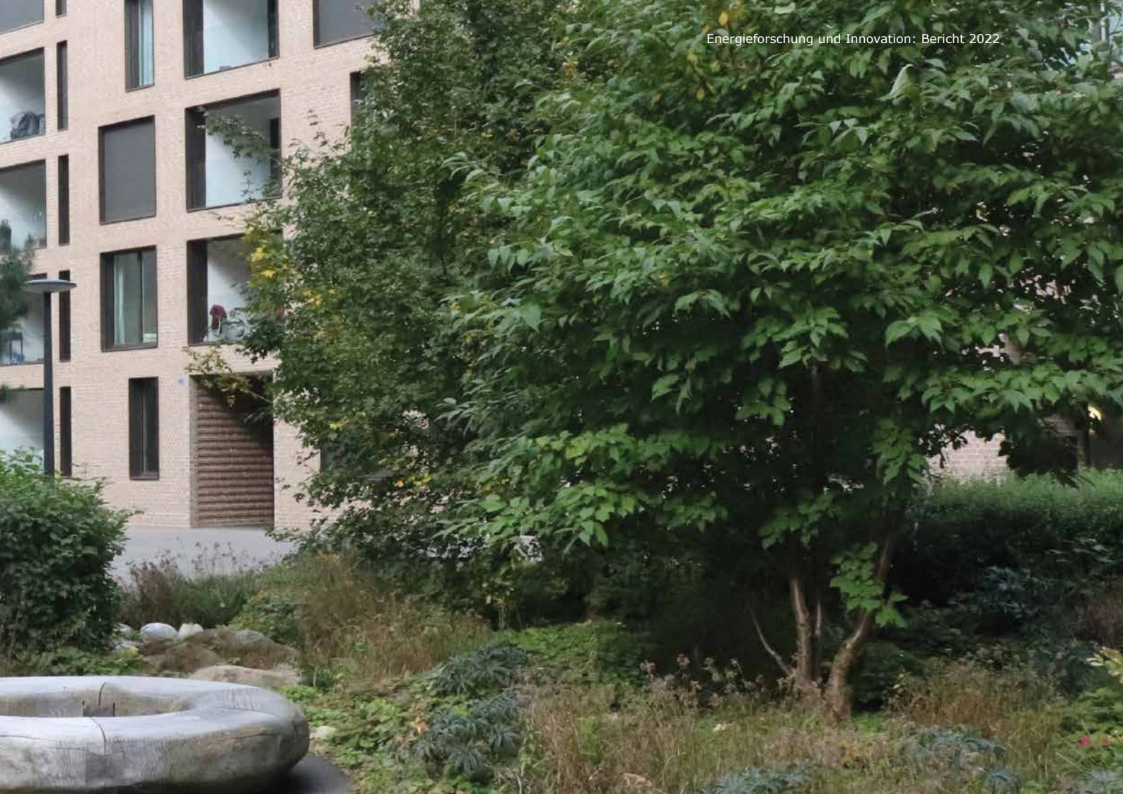
Der Weltpostpark im Osten der Stadt Bern umfasst drei Gebäude, die nach den Vorgaben von Minergie-Eco erbaut wurden. Die Überbauung als Ganzes erfüllt zudem die Kriterien des Labels «2000-Watt-Areal» (Bildquelle: B. Vogel).
