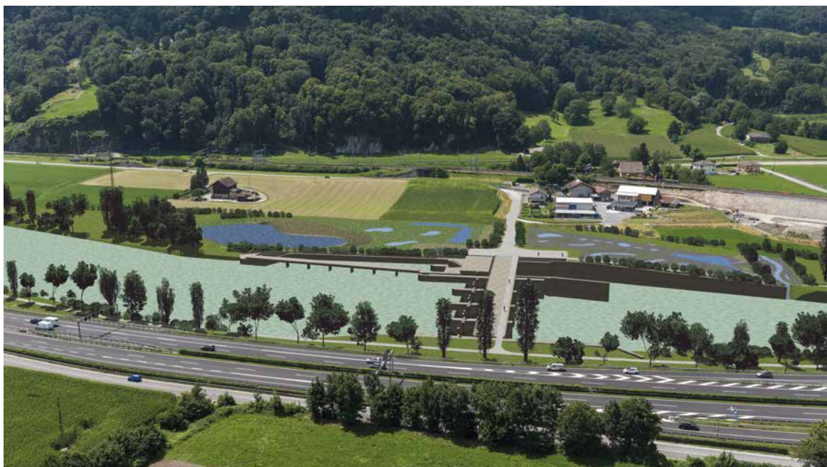
Das Laufwasserkraftwerk Massongex-Bex-Rhône soll 2028 in Betrieb genommen werden und jährlich rund 80 GWh Strom produzieren. Um die Auswirkungen der Stauanlage auf das Rhonebett möglichst tief zu halten, sind verschiedene Ausgleichsmassnahmen vorgesehen. Für den Schutz der Fische entwickeln Forschende der ETH Zürich einen neuartigen Fischleitrochen. Dieser soll abwärts wandernde Fische in das für sie vorgesehene Bypass-System und um das Kraftwerk herum lotsen (Bildquelle: MBR SA).
