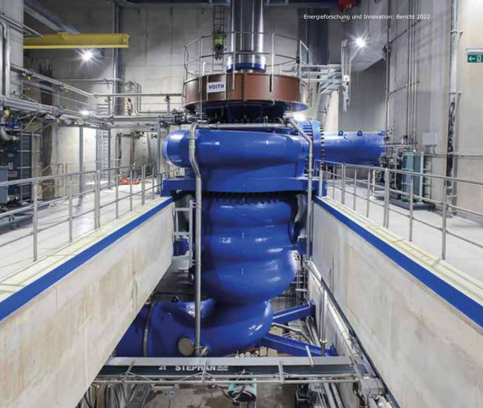
Pumpspeicherkraftwerke können Schwankungen im Stromnetz ausgleichen. Dazu nutzen sie überschüssigen Strom, um Wasser zurück in den Stausee zu pumpen oder überbrücken Engpässe, indem sie gespeichertes Wasser turbinieren. Im Kraftwerk Veytaux wird nun untersucht, wie sich dieser Ausgleich optimieren lässt (Bildquelle: Forces Motrices Hongrin-Léman SA (FMHL)/David Picard).
