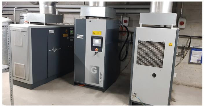
Kompressoren stellen Druckluft zum Betrieb von Pneumatikzylindern bereit. Zur Erzeugung eines Kubikmeters Druckluft werden 0.1 bis 0.14 kWh Strom benötigt. Foto: Cyltronic
