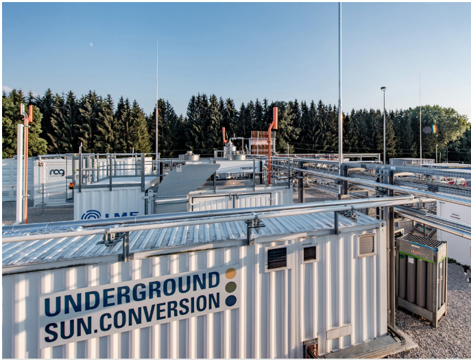
Pilotanlage für Geo-Methanisierung in einer ausgeförderten Erdgaslagerstätte im österreichischen Pilsbach. In einer Tiefe von 1000 Metern werden Wasserstoff und CO 2 von Archaeen in Methan umgewandelt, dies bei Drücken von bis zu 107 bar und einer Temperatur von 40 °C. Foto: RAG Austria AG
