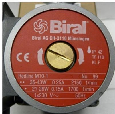
Abbildung 2: Typenschild Pumpe, Quelle: Biral Redline M10-1
