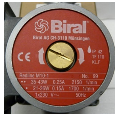
Abbildung 2: Typenschild Pumpe, Quelle: Biral Redline M10-1
