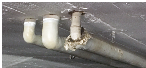
Defekte Wärmedämmungen reparieren.
