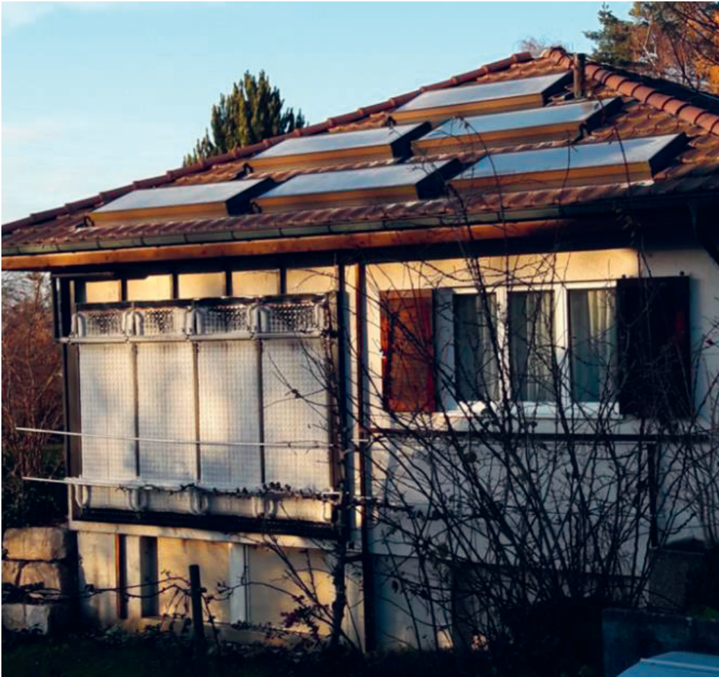
Bild 4: Südseite der Liegenschaft Winzerstrasse 9, 8353 Elgg
