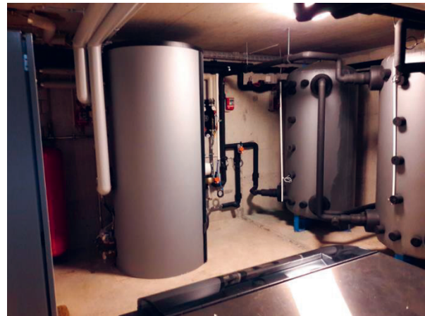
Bild 5 (li): Wärmepumpe und Heizungsspeicher mit Expansionsgefäss (rot)
