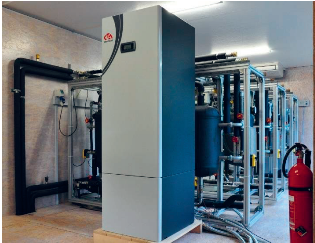
Abbildung 4: Wärmepumpensystem Optiheat In-verta TWW - CTA AG
