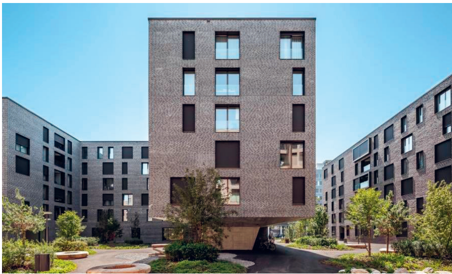
Abbildung 1: Haus A und Haus C [1]
