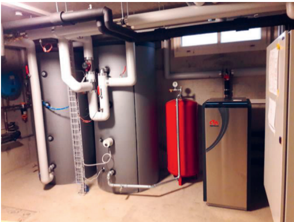
Bild 5 (li): Wärmepumpe und Heizungsspeicher mit Expansionsgefäss (rot)
