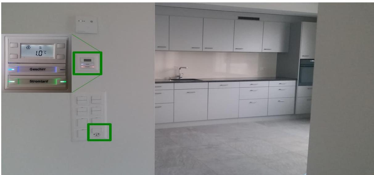
*Bild 2: Ausrüstung der Wohnungen mit KNX-Raumbediengeräten*
