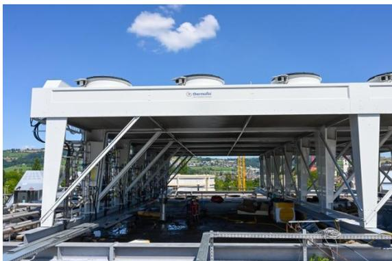
*Bild 3: Gaskühler mit Aussenverdampfer.*
