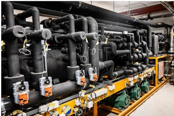
*Bild 2: Reversible CO<sub>2</sub>-Wärmepumpe.*
