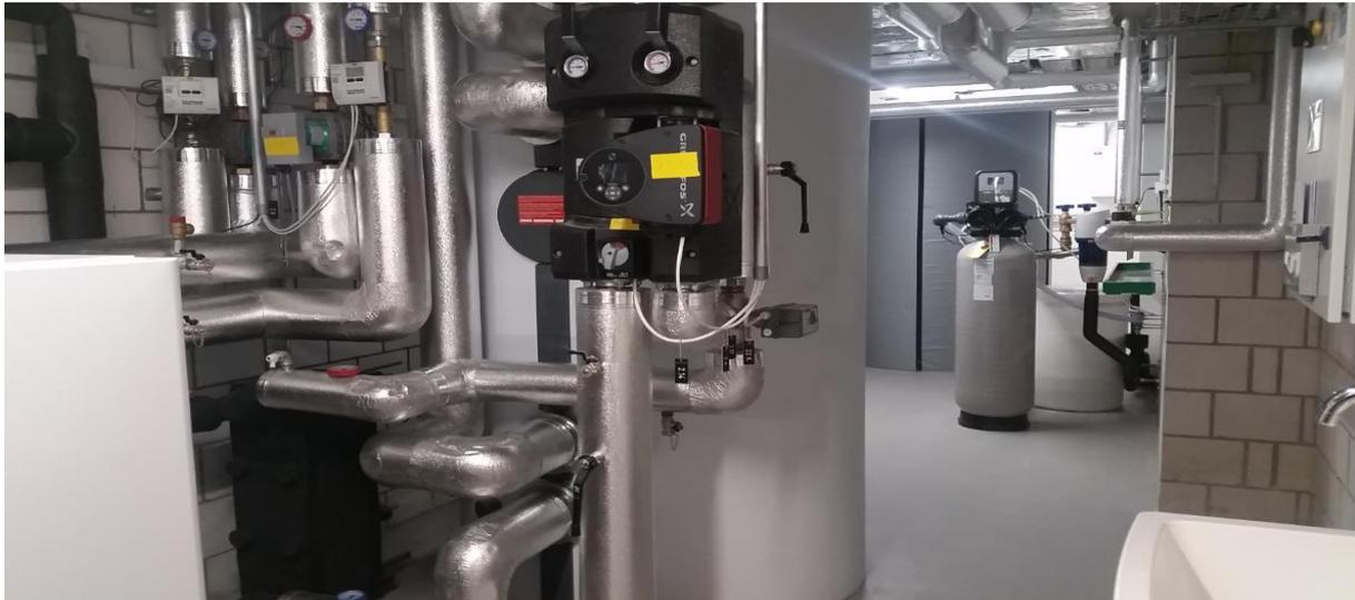
*Bild 3: Vordergrund: Wärmepumpe mit Heizkreis und Pufferspeicher, Hintergrund: Speicher für Brauchwarmwasser*
