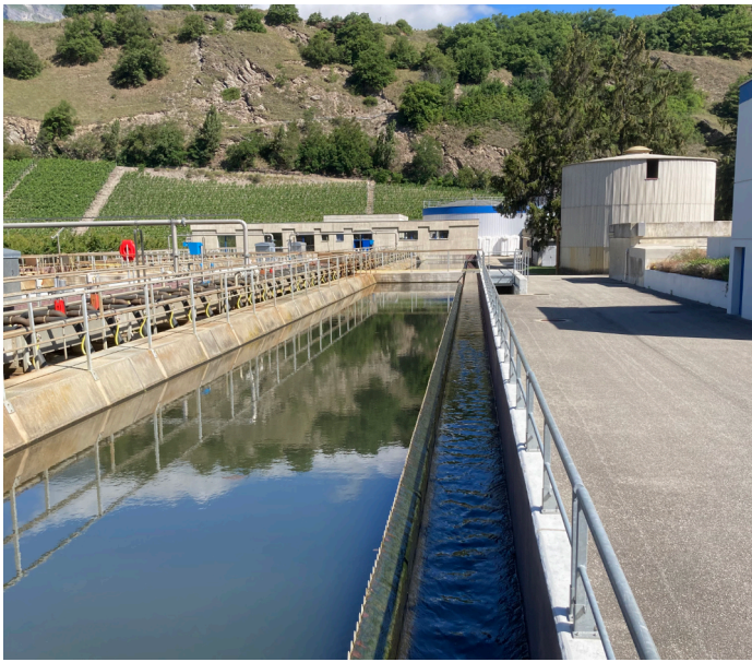
Die Abwasserreinigungsanlage (ARA) Châteauneuf unweit von Sitten (VS). Im Vordergrund ist die biologische Reinigungsstufe zu sehen. Hier fällt der Klärschlamm an, der im Fermenter (weiss-blaues Gebäude im Hintergrund) zur Herstellung von Biogas genutzt wird, aus dem in einer Wärme-Kraft-Kopplungs-Anlage Wärme und Strom gewonnen werden. Den Klärschlamm aus der ARA Châteauneuf nutzen die Walliser Forscher in der Mikrobiellen Elektrolysezelle. Foto: B. Vogel
