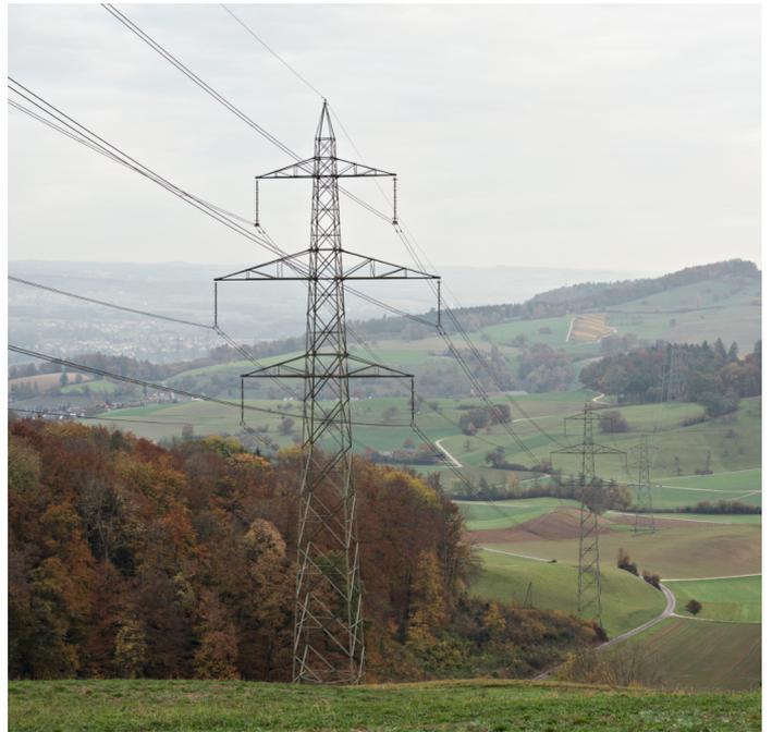
Wenn in der europaweiten Stromversorgung – im Bild eine Freileitung zwischen Gösgen und Laufenburg – 3 GW Produktionsleistung ausfallen, sinkt die Frequenz im Netz um 0,2 Hertz. Foto: Swissgrid
