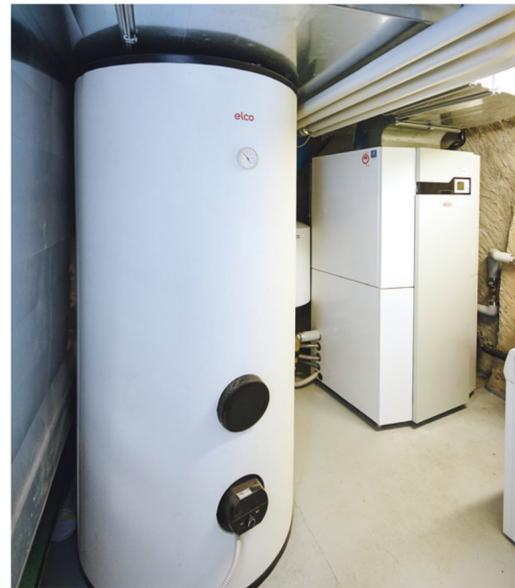
Das neue Heizsystem: eine innenaufgestellte Luft-Wasser-Wärmepumpe (rechts) mit Speicher für Solarthermie.
