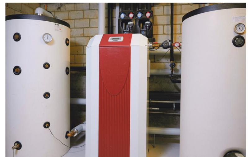
Aus Solarstrom wird speicherbare Wärme: Eine Wärmepumpe (Mitte) und gedämmte Wassertanks machen es möglich.
