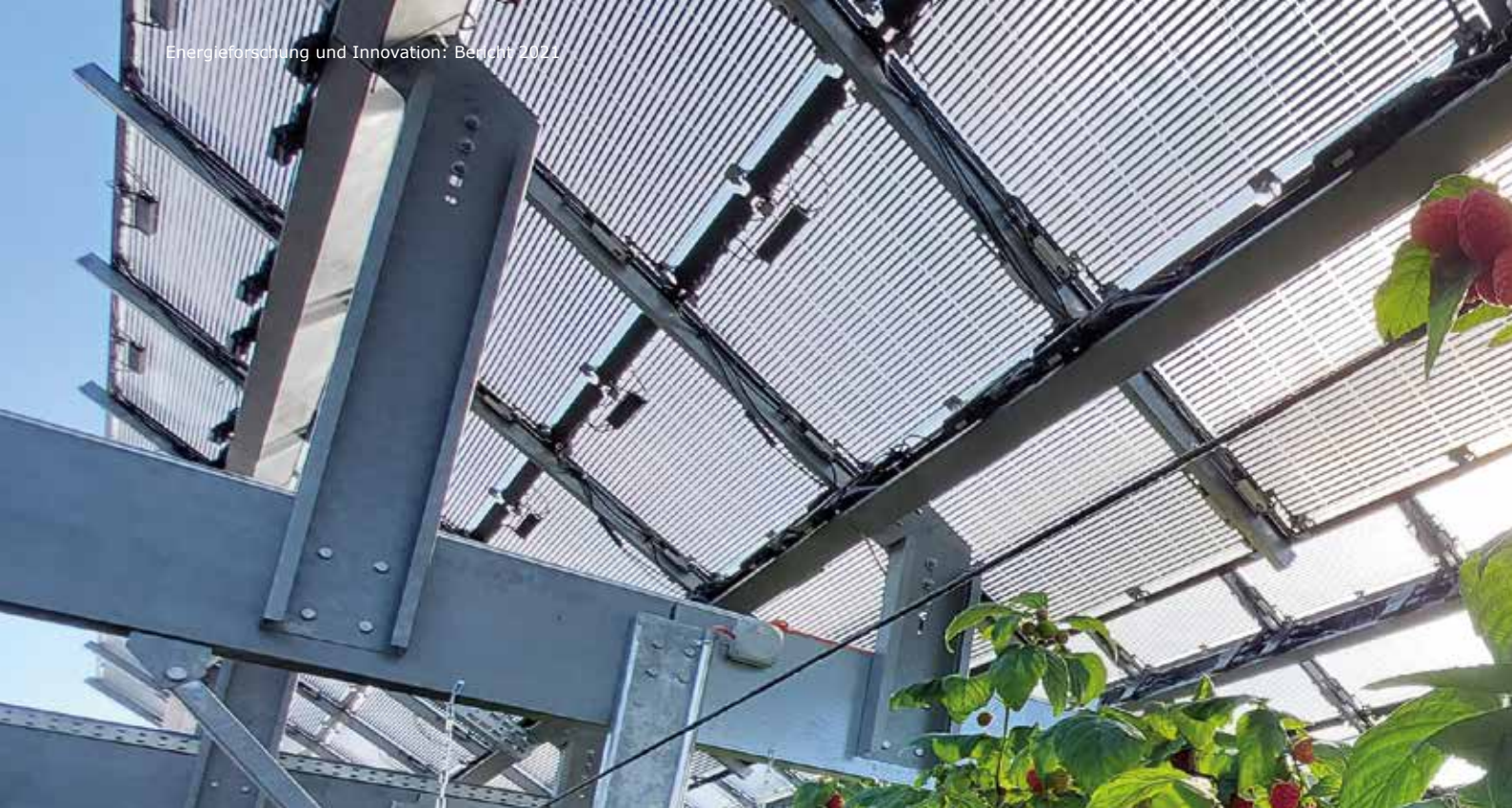
Photovoltaikpilotanlage am Agroscope-Versuchsstandort Conthey (VS), wo Module mit modulierbarer Transparenz über einer Himbeerkultur installiert sind, so dass die darunter wachsenden Pflanzen mehr oder weniger stark beschattet werden. Die Solarmodule wurden von der Schweizer Firma Insolight speziell für solche Anwendungen konzipiert (Quelle: Agroscope).
