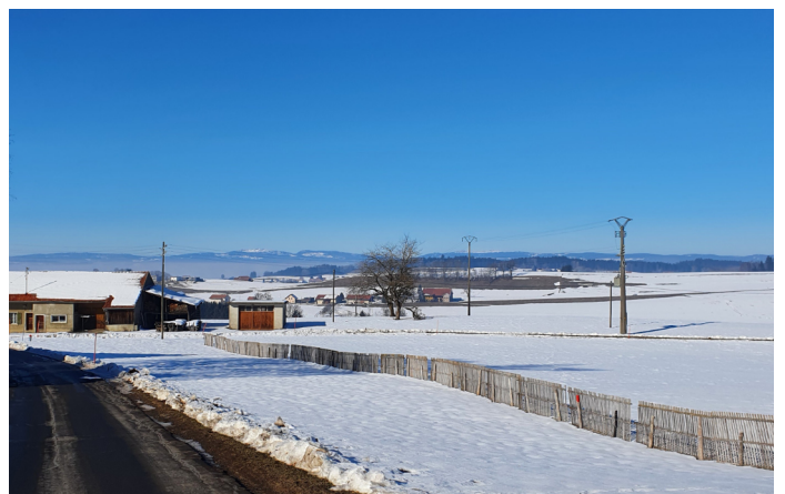
Das Verteilnetz der Groupe E in Haut de Fiaugères (FR) steht beispielhaft für ein ländliches Stromnetz. Das BFH-TI-Projekt geht davon aus, dass die installierte PV-Leistung in diesem Netz von heute 32 auf 362 kWp im Jahr 2035 zunehmen wird. Foto: Groupe E
