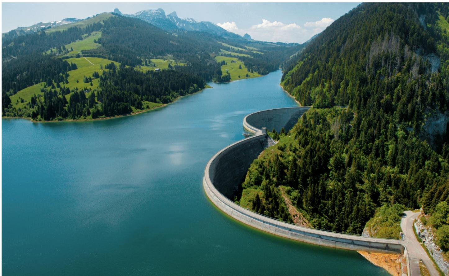
Der Hongrin-Stausee des Waadtländer Pumpspeicherkraftwerks FMHL (Betreiberin: Forces Motrices Hongrin-Léman SA) mit seiner doppelten Bogenstaumauer. Im Rahmen des Pilot- und Demonstrationsprojekts HydroLEAP wird an dem Kraftwerk das Potenzial des Hydraulischen-Kurzschluss-Betriebs zur Bereitstellung von stufenloser negativer Regelleistung erforscht. Ein zweites Teilprojekt untersucht die Auswirkungen eines akzentuierten Start-Stop-Betriebs auf den Verschleiss von Turbinen und Pumpen. Foto: Alpiq
