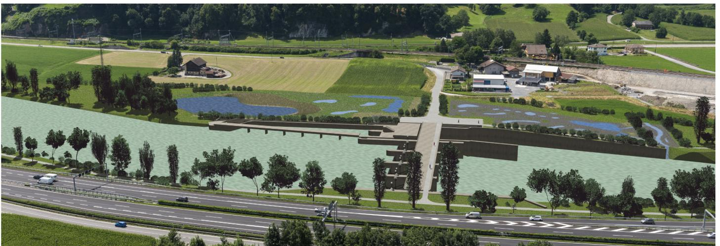
Visualisierung des neuen Flusskraftwerks in Massongex im Unterwallis, das sich zur Zeit in Planung befindet. Das Kraftwerk ist ein Demonstrationsstandort des HydroLEAP-Projekts. Forscherinnen und Forscher der Eidgenössisch Technischen Hochschule Zürich untersuchen hier ein fortschrittliches Sedimentmanagement sowie die Minimierung der Umweltauswirkungen von neuen Laufwasserkraftwerken. Visualisierung: MBR
