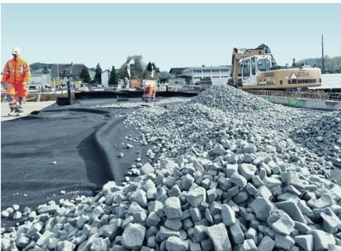
Abb. 85: Schaumglasschotter auf einem Geotextil. © Misapor.ch
