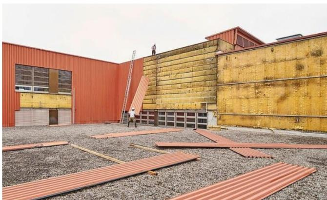
Abb. 76: Gebrauchte Fassadenteile werden für die Wiederverwendung beim Gebäude 118 am Lagerplatz Winterthur rückgebaut. © Martin Zeller
