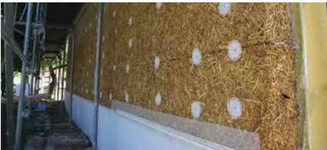
Abb. 78: Strohdämmplatte als WDVS. © Franken Maxit Mauermörtel GmbH & Co
