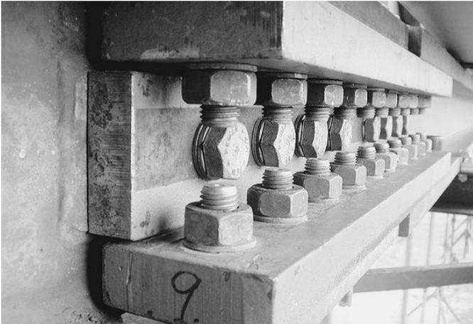
Abb. 77: Geschraubte statt geschweisste Verbindung im Stahlbau. © Foto: [bauforumstahl](#) / G. Machura
