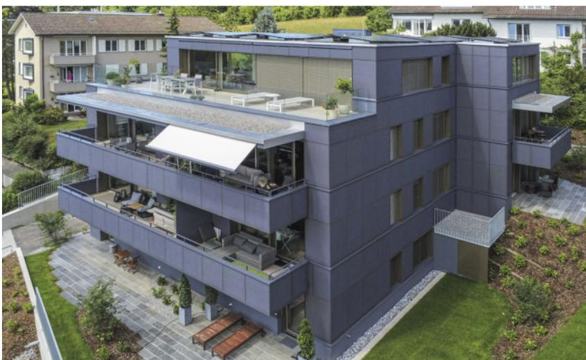
Abbildung 26: Graue monokristalline Photovoltaik-Module an der Fassade eines PlusEnergie-Mehrfamilienhauses (Quelle: [www.solaragentur.ch](http://www.solaragentur.ch)).
