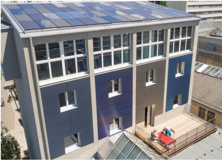
Abbildung 27: Verschiedenfarbige Photovoltaikmodule an der Fassade und auf dem Dach eines Gebäudes in Basel (Quelle: [www.solarchitecture.ch](http://www.solarchitecture.ch)).
