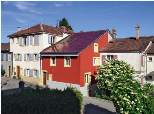
Abbildung 22: Mit einem farbigen Filter laminierte Dünnschicht-Zellen auf dem Dach eines Einfamilienhauses in Corcelles (NE) (Quelle: Egger 2015).
