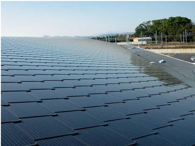
Abbildung 32: Beispiel einer dachintegrierten Anlage. Die einzelnen Dünnschichtmodule sind quadratisch und sind an den Ecken abgerundet (Quelle: [www.tectonica-online.com](http://www.tectonica-online.com))
