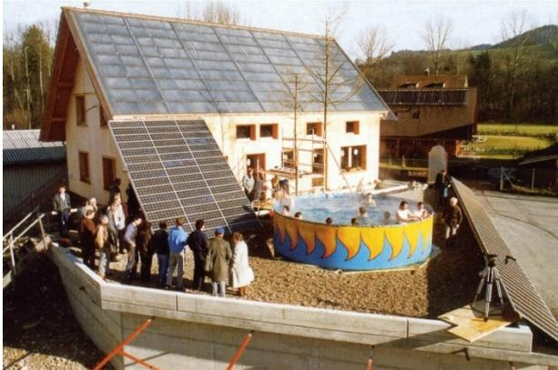
Abbildung 68: Das erste solar beheizte Einfamilienhaus der Schweiz in Oberburg im Januar 1990. Der skeptischen Fachwelt wurde durch die Speisung eines Aussenpools an einem Wintertag gezeigt, dass das Haus über genügend Wärme verfügte (Quelle: <http://jenni.ch/bauprojekte-jenni.html>).
