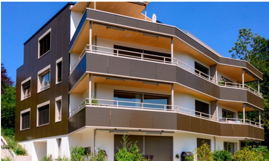
Abbildung 28: Dekorative keramisch bedruckte Module mit Karamustern an einem Plusenergiegebäude in Zürich (Quelle: [www.solarchitecture.ch](http://www.solarchitecture.ch)).
