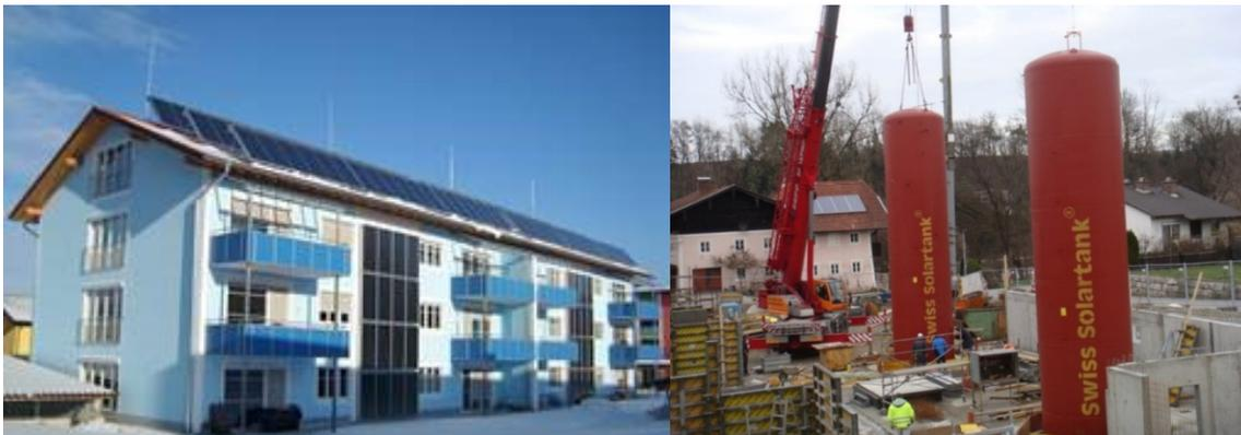
Abbildung 69: Beispiel eines Solarhauses im bayerischen Laufen (Quelle: <http://www.solar-partner-sued.de/aktuelles/informationen/einzelsicht/article/speichereinbringung-bei-mf-sonnenhaeusern-laufen.html>).
