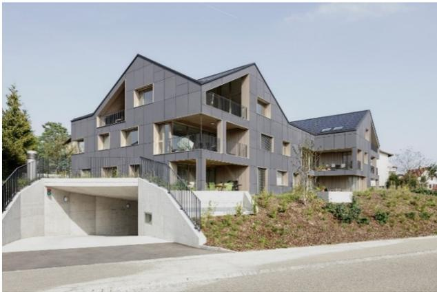
Abbildung 21: Sandgestrahlte Dünnschicht-Zellen an der Fassade eines energieautarken Mehrfamilienhauses in Brütten (AG) (Quelle: [www.umweltarena.ch](http://www.umweltarena.ch)).
