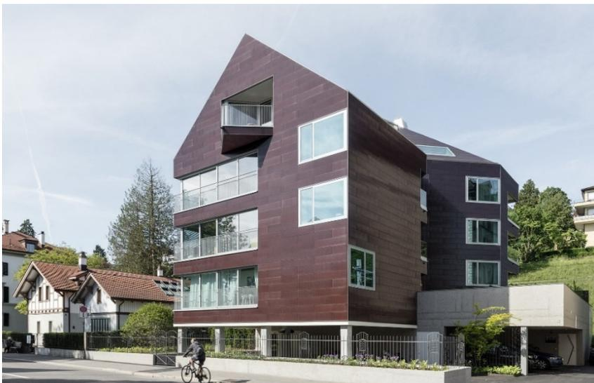
Abbildung 25: Photovoltaikmodule im Verbundsystem mit strukturiertem auberginefarbenen Gussglas am Wohnhaus Solaris in Zürich (Quelle: [openhouse-zuerich.org](http://openhouse-zuerich.org)).
