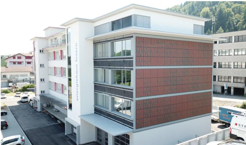
Abbildung 29: Energiehaus Luzern mit gemusterter, zinnroter Photovoltaikfassade (Quelle <https://www.ee-news.ch/de/article/41769/be-netz-die-vernetzer-netzen-fortan-im-energiehaus-in-luzern>).
