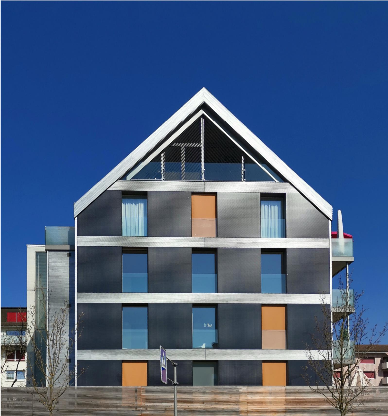
Integrierte Photovoltaik in der Gebäudehülle ermöglicht eine dezentrale Stromerzeugung aus erneuerbaren Energien im Gebäudebereich. Im Rahmen der Energiestrategie 2050 kann diese in Neu- oder in Bestandesbauten für den Eigenverbrauch, die Elektromobilität oder den weiteren Verkauf verwendet werden. Integrierte Photovoltaik leistet somit einen Beitrag zur Reduktion der CO<sub>2</sub>-Emissionen und zur Energiezukunft.
