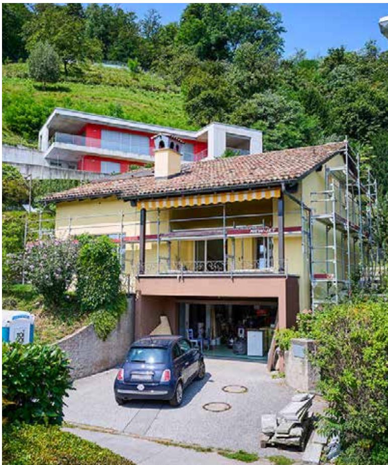
Erneuerung kurz vor Abschluss: Das Haus von Michela Sormani und Daniele Grespi.
