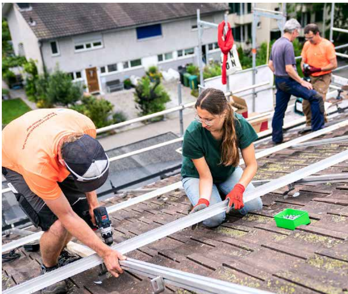
Die Bauleiter in den orangenen T-Shirts sind für Instruktion, Arbeitssicherheit und komplexere Arbeitsschritte zuständig.
