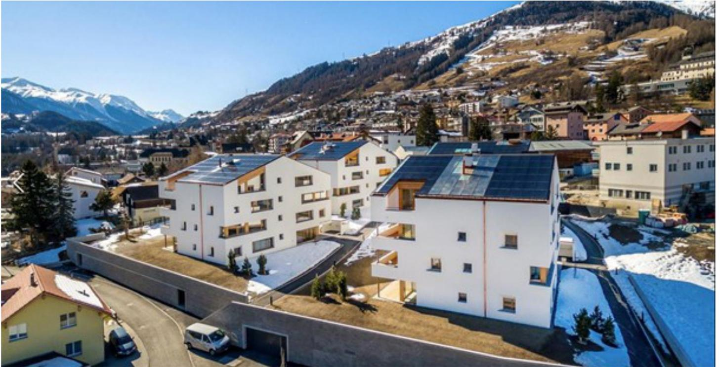
Die Monolit-Überbauung in Scuol besteht aus vier Häusern; drei wurden in das BFE-Projekt einbezogen: Vorne links Haus A mit einer reinen PV-Anlage, dahinter Haus B mit PVT-Modulen. Vorne rechts Haus C: Das Dach ist in der Mitte mit Warmwasserkollektoren bestückt, beidseitig von PV-Modulen begleitet, an der unterschiedlichen Optik klar erkennbar. Foto: Fanzun AG
