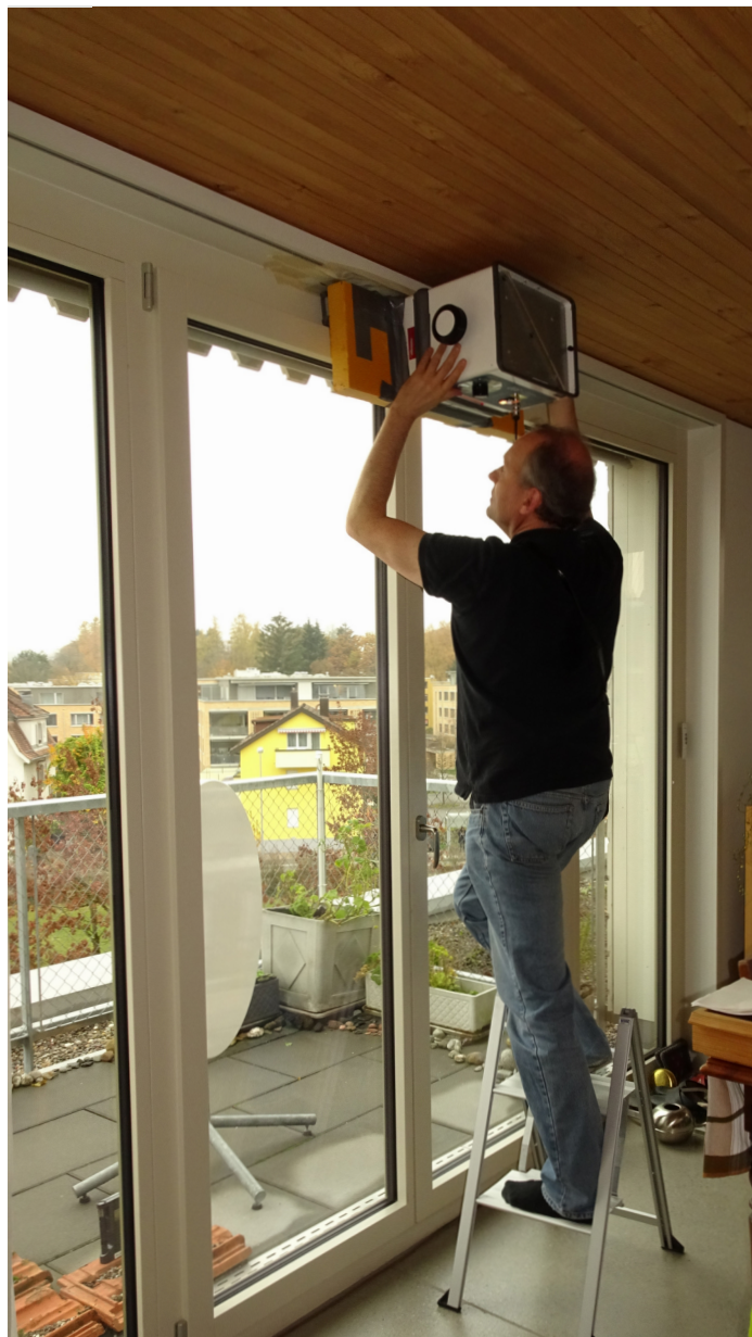
Im Rahmen eines Forschungsprojekts haben Wissenschaftlerinnen und Wissenschaftler der Fachhochschule Nordwestschweiz und der Hochschule Luzern Messungen in acht Wohnungen durchgeführt, die mit Fensterlüftern ausgestattet sind. Im Bild: Einbau eines Geräts zur Messung der Zuluft. Foto: FHNW/HSLU
