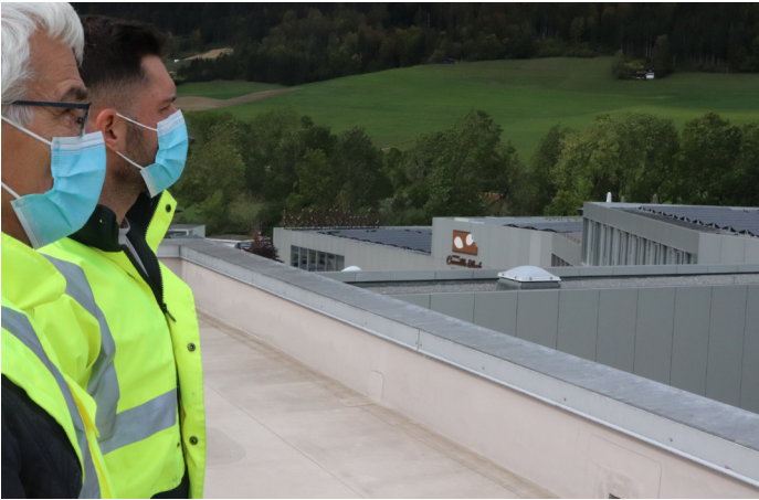
Auf den Dächern der Schokoladenfabrik Camille Bloch in Courtelary (BE) ist eine Solarstromanlage mit einer Leistung von 309 kW p installiert. Links: Jean-Philippe Simon, Leiter Infrastruktur (vorn), zusammen mit seinem Mitarbeiter Nicolas Gentile. Foto: B. Vogel
